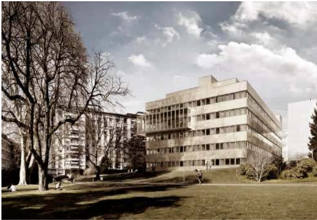
Der provisorische Modulbau dient als Rochadefläche während der Gesamterneuerung des Spitals. Visualisierung PD
